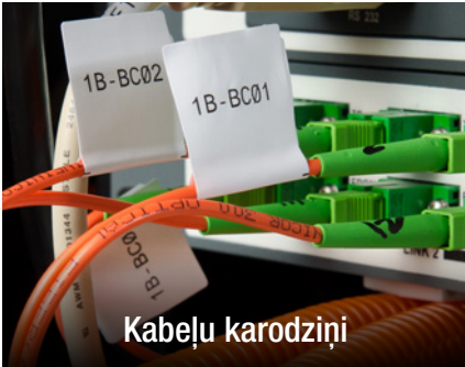
Sadales bloku un komutācijas paneļu etiķetes
